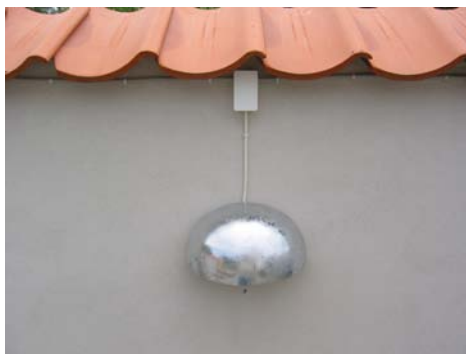
Belysning med kabel/ledning.
