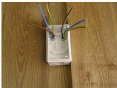
Skjult installation til og afgang.
