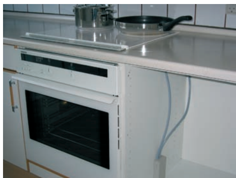
Panelunderlag med udtag for kogeplade og ovn.
