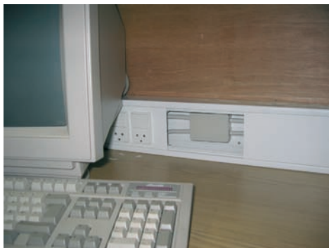
EDB-kanal kabler aflastet i dåsen
